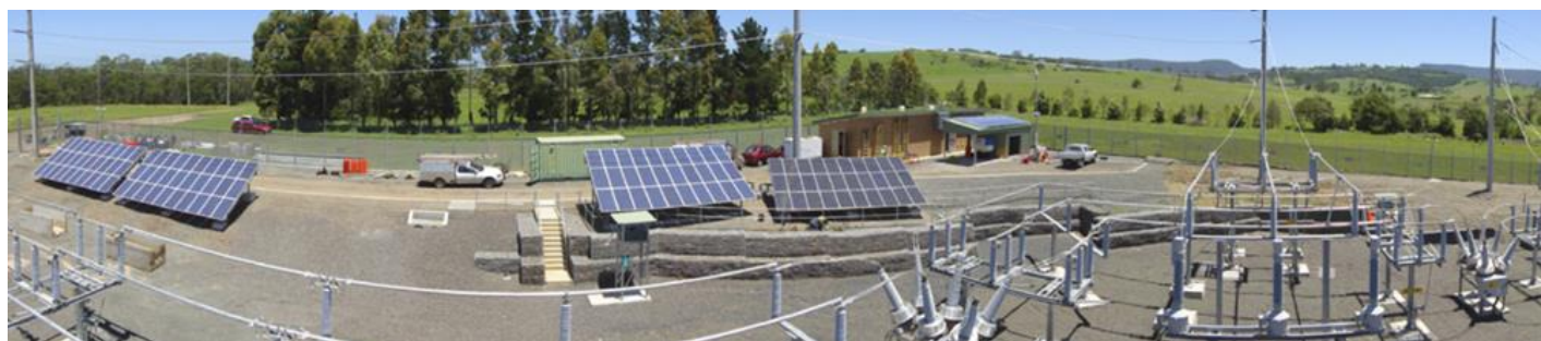
Montaż instalacji fotowoltaicznej na terenie stacji elektroenergetycznej.
